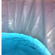
Étanchéité du château d'eau par une bâche
