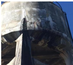
Étanchéité du château d'eau par une bâche
