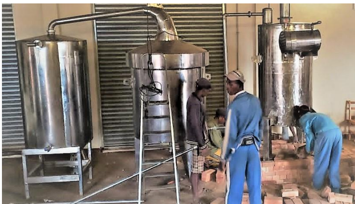
Le 2 ème alambic et chaudière en cours d'installation
